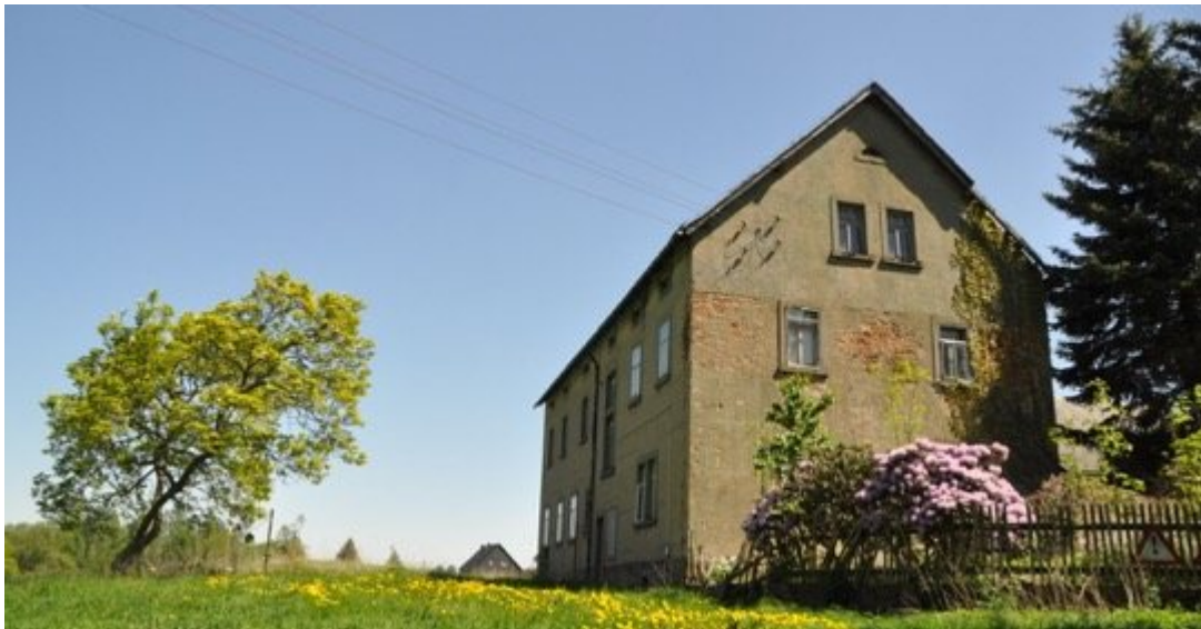
Wohnhaus, derzeitiger Zustand unsaniert, Außenansicht
