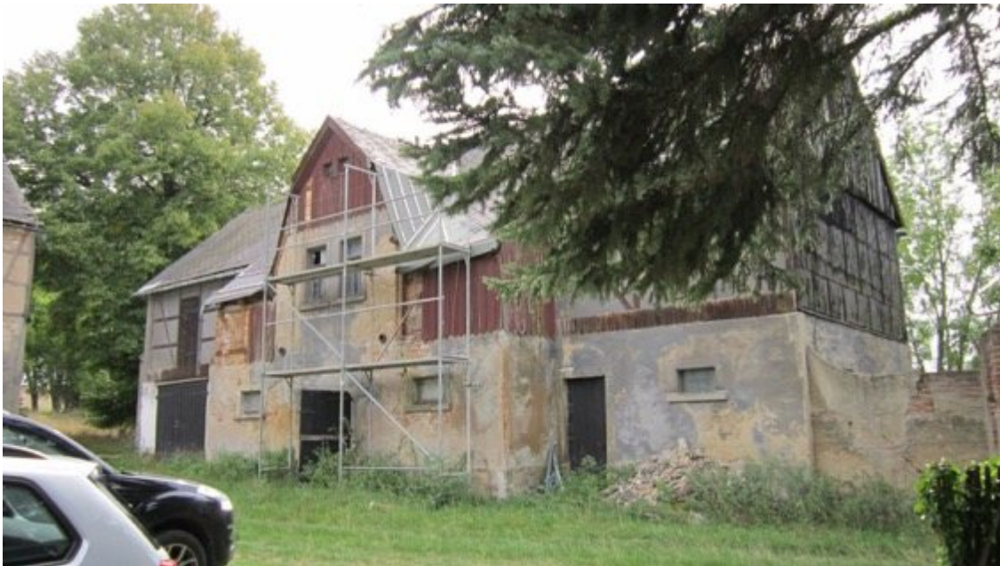
Pferdestall, derzeitiger Zustand unsaniert, Hofseite
