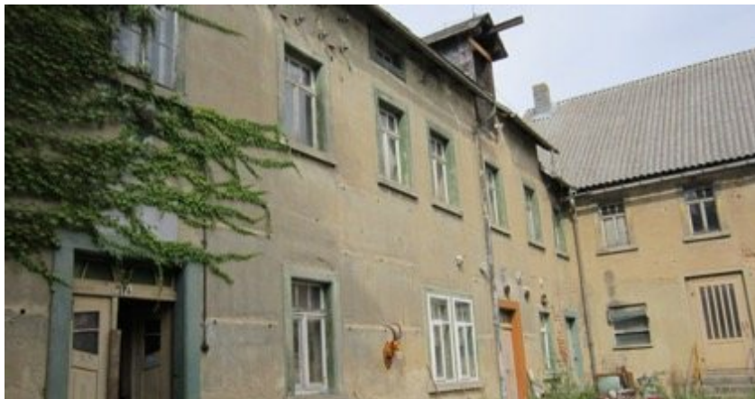
Wohnhaus, derzeitiger Zustand unsaniert, Hofseite
