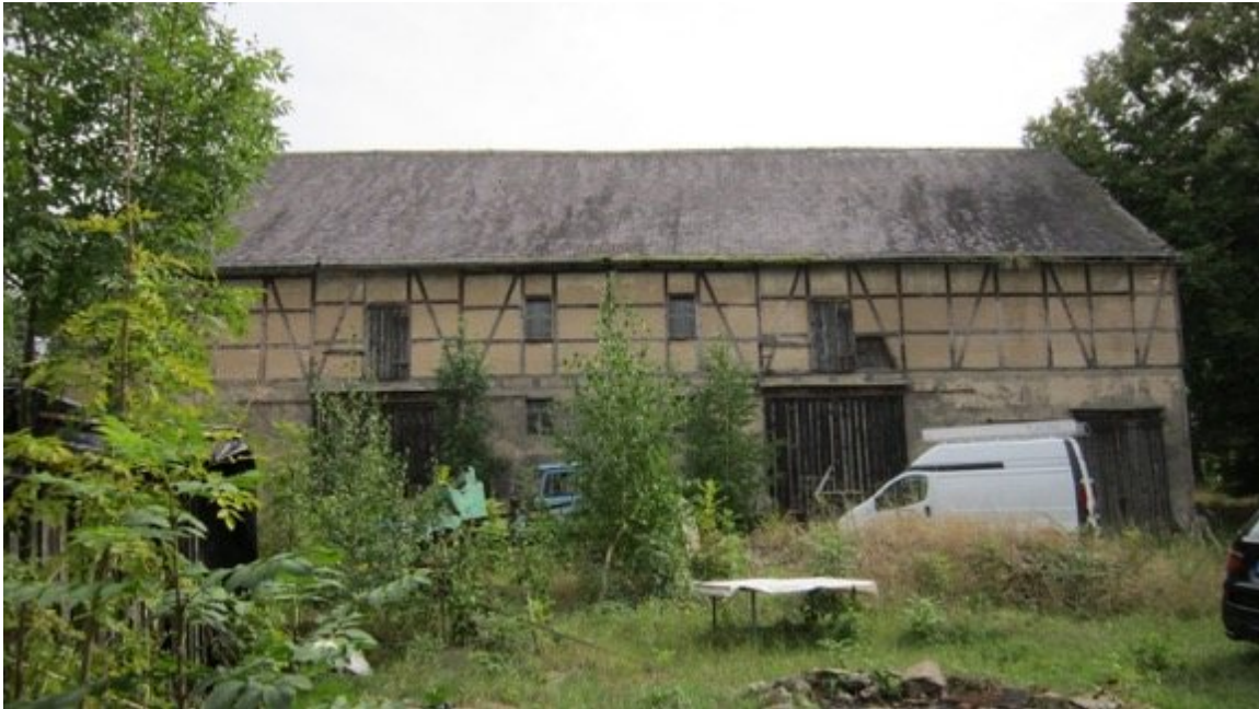
Scheune, derzeitiger Zustand unsaniert, Hofseite
