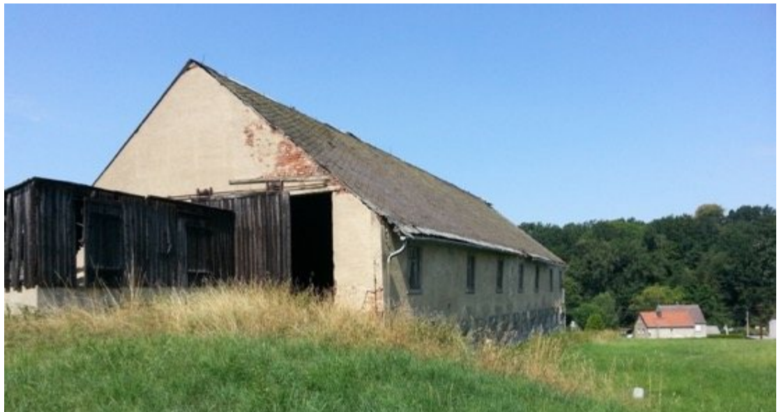
Stall, derzeitiger Zustand unsaniert, Außenansicht
