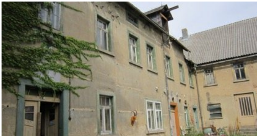
Wohnhaus, derzeitiger Zustand unsaniert, Hofseite
