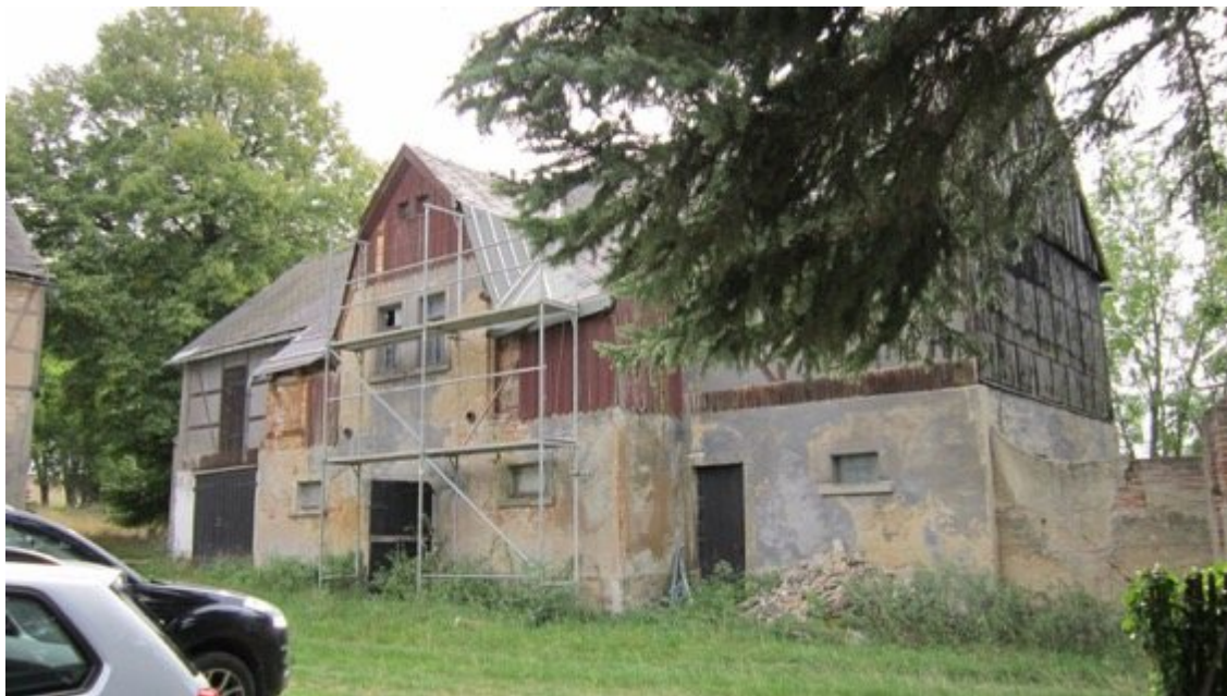
Pferdestall, derzeitiger Zustand unsaniert, Hofseite
